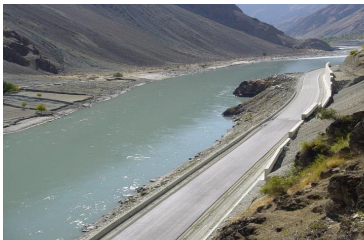
Рисунок 1 - Подпорная стенка на а/д Шкев-Зигар
