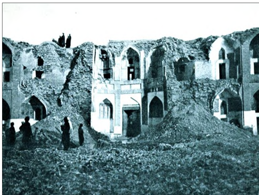
Рис. 3. Разрушения медресе в Денау. Сильное 9-балльное Каратагское землетрясение 1907 г. (фонды ИГССС НАНТ).
