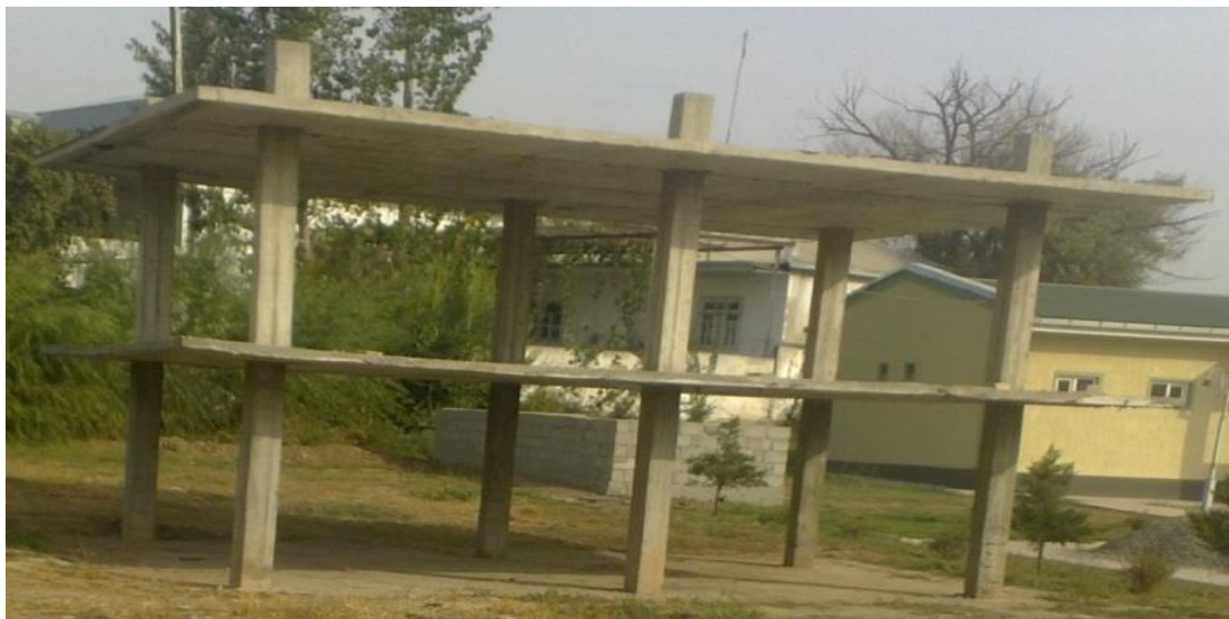
Рами 1. Намуди умумии бинои душӯнаи синҷи беболор аз оҳанубетонӣ монолитӣ бо армиронии муқаррарӣ дар полигон озмоишгоҳӣ кафедраи ССШ
