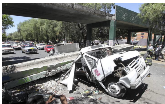
Рисунок 2. Разрушение надземного переход пешеходного перехода в Мексике
