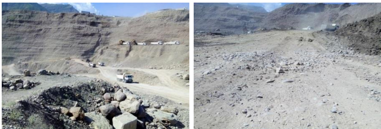
Рисунок 3 - Особенности горных карьерных дорог в условиях строительства Рогунской ГЭС
