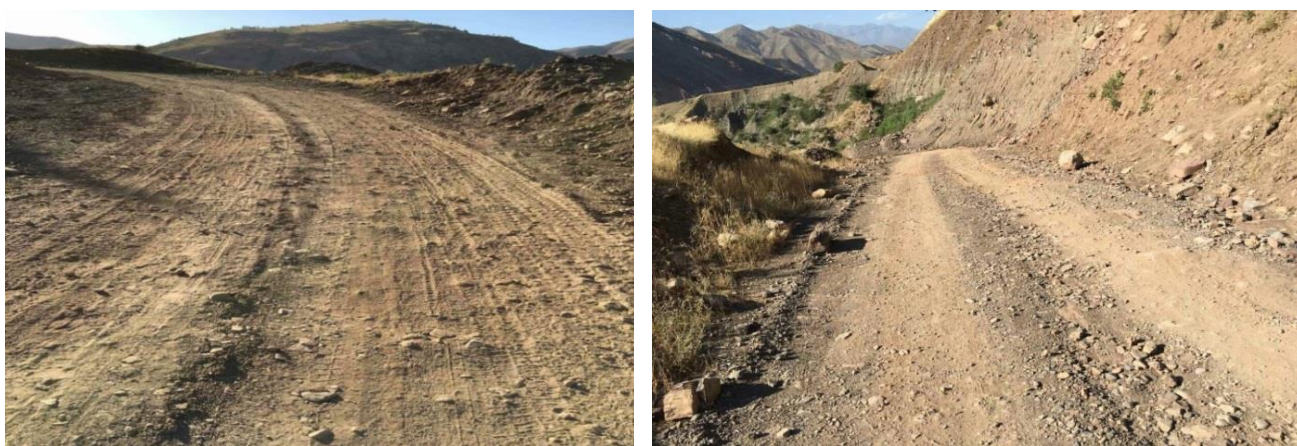
Рисунок 2.2 – Участки горных карьерных дорог на строительстве Рогунской ГЭС.
