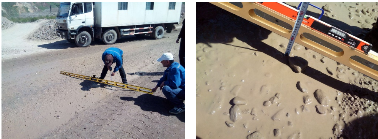
Рисунок 2.10 – Процесс измерения неровностей дорожной одежды при помощи универсальной дорожной рейки РДУ «Кондор»
