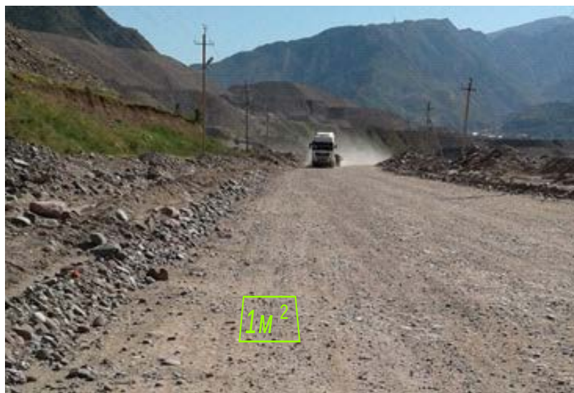
Рисунок 2.7 – Фрагмент участка горной карьерной автодороги, на поверхности которой засыпаны дресвяные и щебенистые обломки горных пород, а на обочинах имеются скопление камней различных размеров (крупных, средних и мелких)
