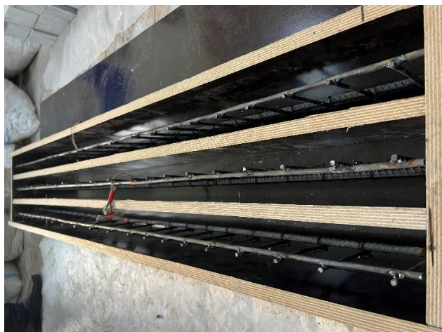
Рисунок 3.11. Этап подготовки опалубки и монтажа арматурных каркасов
