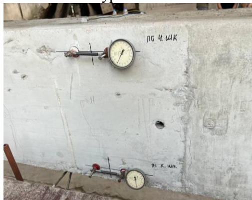
Измерение деформации бетона на базе 100мм
