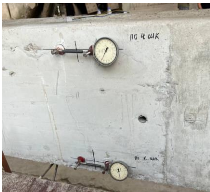
Измерение деформации бетона на базе 100мм
