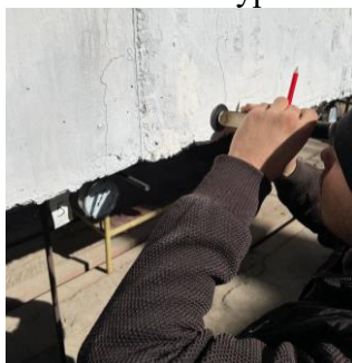
Процесс измерения ширины раскрытия трещин
