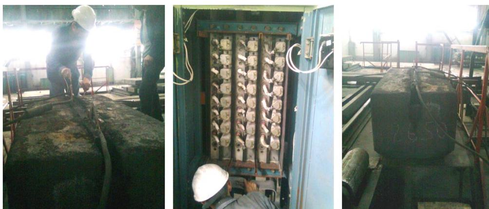
**Рисунок 4.2** - Электрические испытания. Замер перепада электрического напряжения между анодом и кронштейном при зазоре 0,5 мм и силе тока 2 кА
