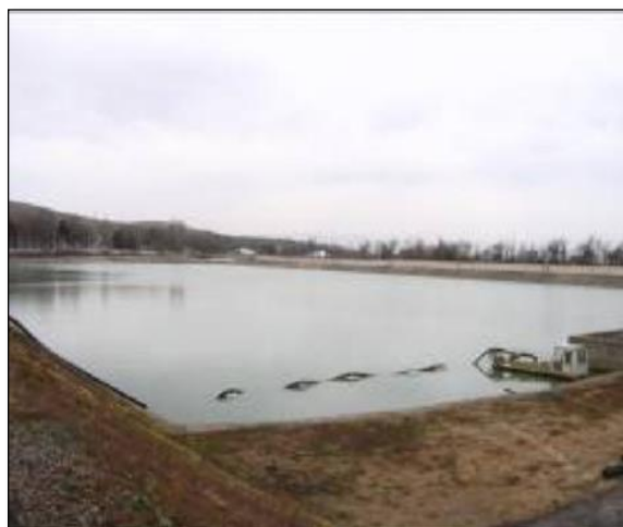
Рисунок 1.3. - Бассейн суточного Регулирования очистной станции самотечного водопровода
