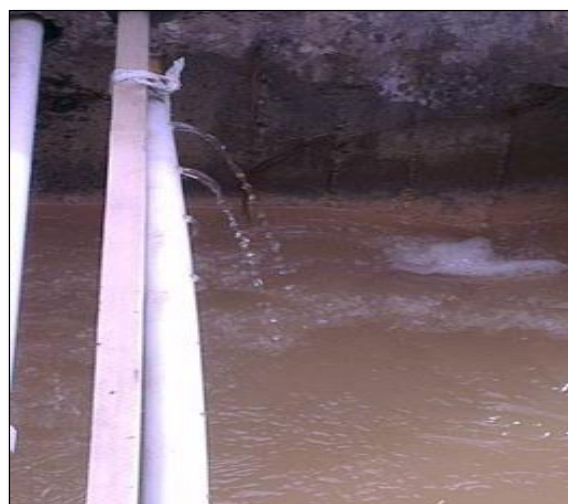
Рисунок 1.7. - Ввод раствора сульфата алюминия в неочищенную воду
