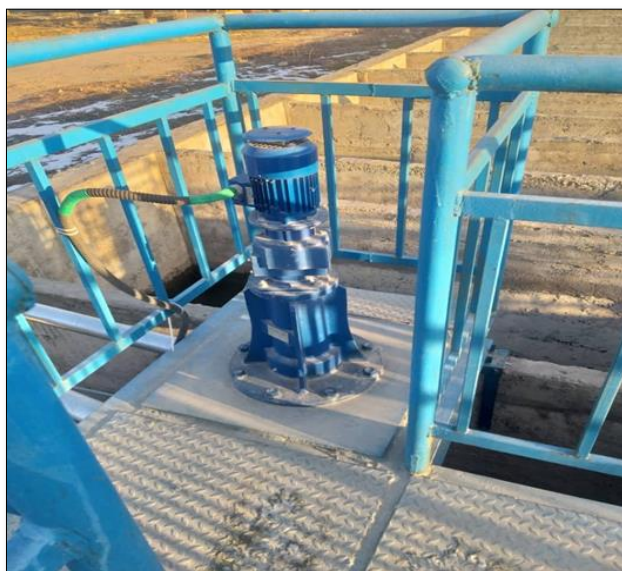
Рисунок 5.3. - Вид на камеры для быстрого смешивания раствора
