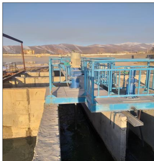
Рисунок 5.3. - Вид на камеры для быстрого смешивания раствора
