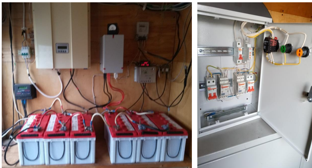
Рисунок - 3.29. Схема переключения на резервную источник питания через АВР: слева – показано АКБ и контроллеры ВЭУ и ФЭП; справа – АВР
