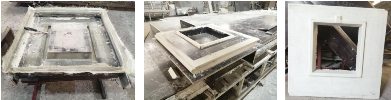
Рисунок 10. - Процесс изготовления опалубки и общий вид ТНСП
