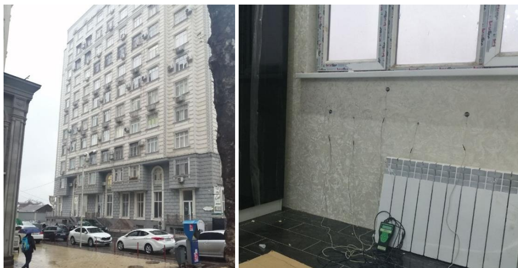
Рисунок 2.9. – Процесс проведения исследования кирпичной стены с фибробетонным покрытием
