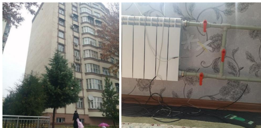
Рисунок 2.6. - Процесс проведения исследования кирпичной стены с утеплением
