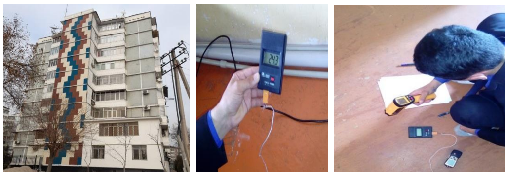
Рисунок 2.1. - Виды зданий и время исследований микроклимата в помещениях трёх комнатной квартиры существующего крупнопанельного здания
