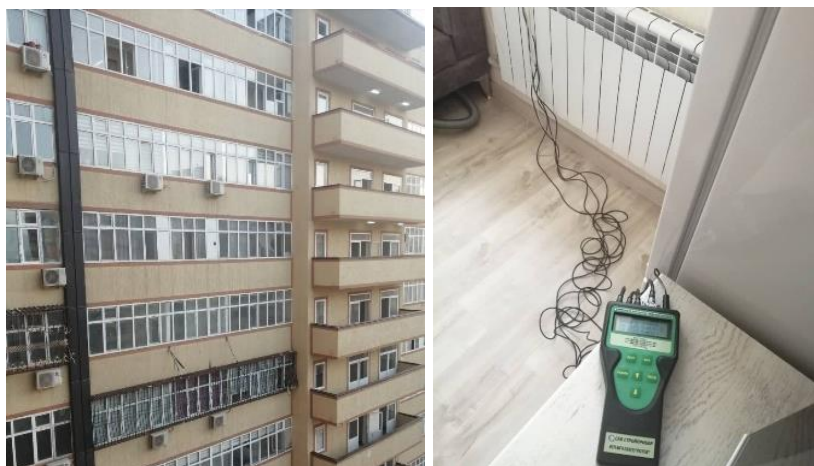
Рисунок 2.3. Процесс проведения исследования кирпичной стены без утепления
