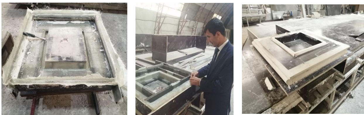
Рисунок 4.1. - Процесс изготовления опалубки ТНСП
