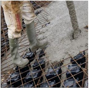
Рисунок 1.4. - Бетонирование Airdeck
