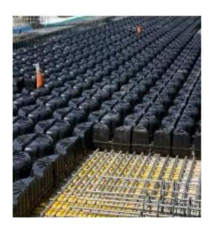
Рисунок 1.8. - Вкладыши Cobiax
