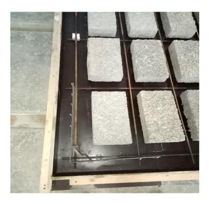
Рисунок 2.3. - Ребро жесткости и арболитовые блоки
