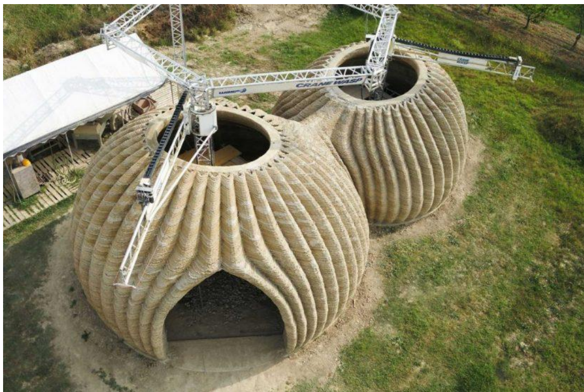
Рисунок 3.1. Пример использования 3d печати при строительстве дома
